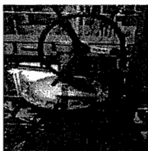
主蒸気逃がし弁の手動操作ハンドル
