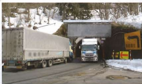
揚川トンネルですれ違いができず待機する大型車
