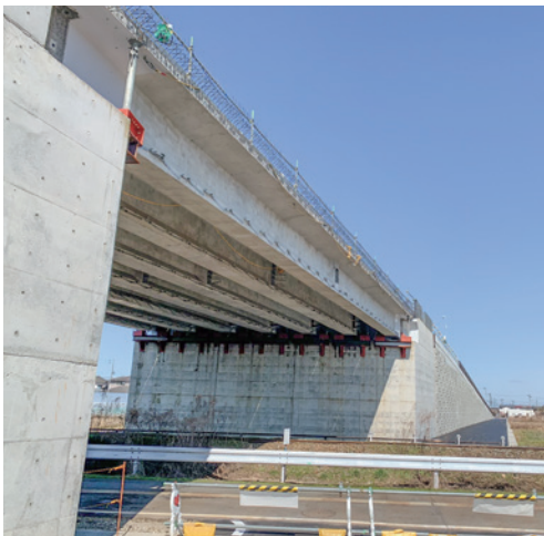
東南環状線 跨線橋上部工
